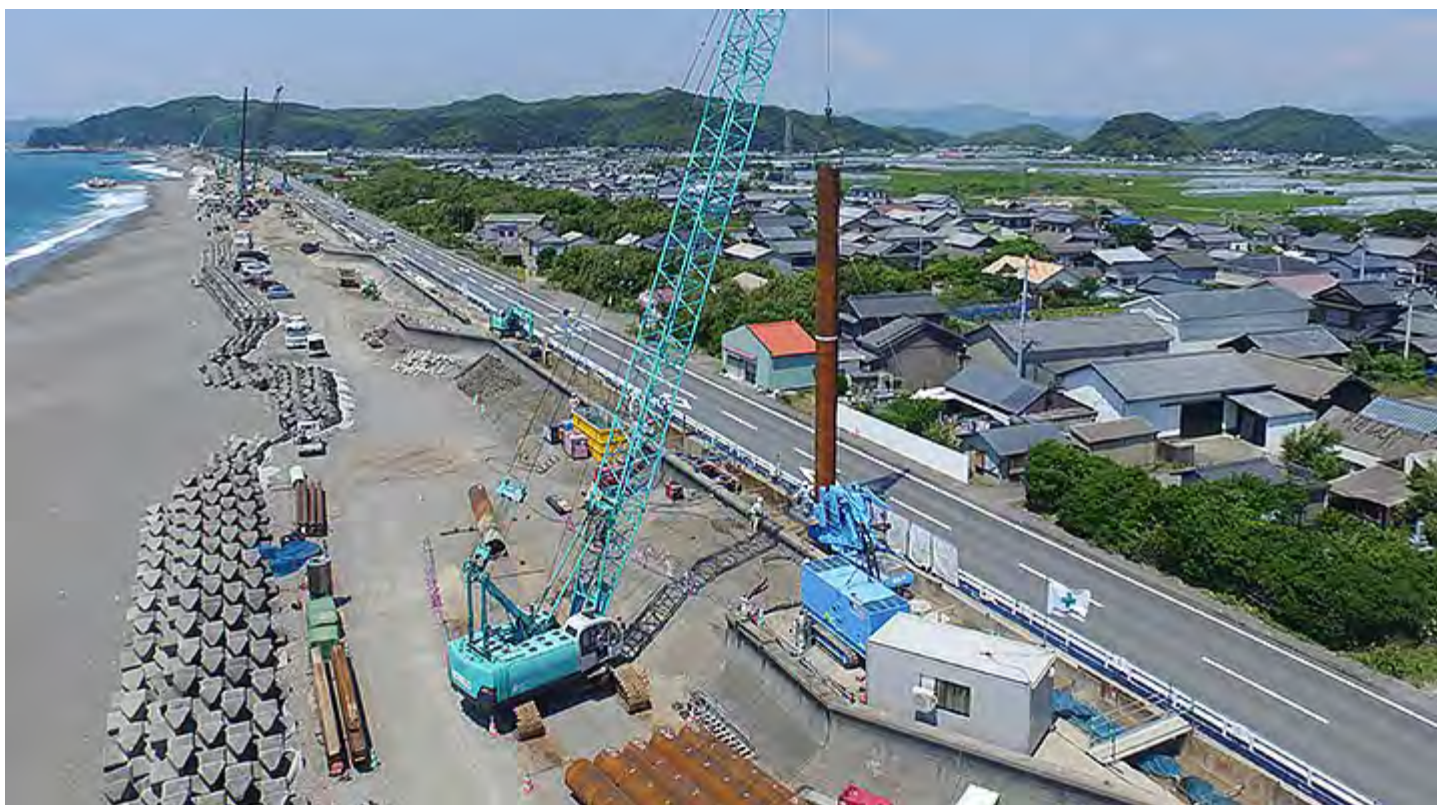
高知海岸（戸原工区）で整備中の「インプラント堤防」
