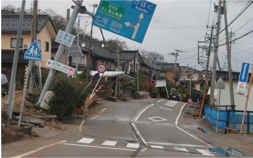
県道部の変形（隆起）の様子
