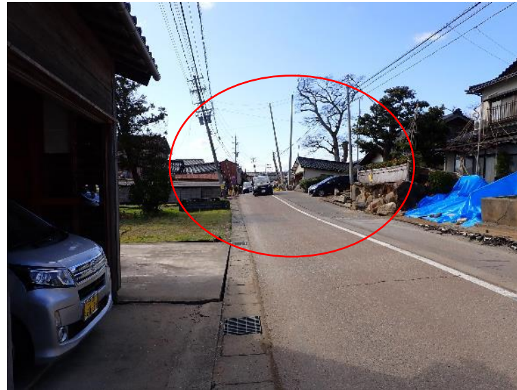
路面の隆起（圧縮変形），電柱傾倒 ：県道8号線 かほく市大崎
