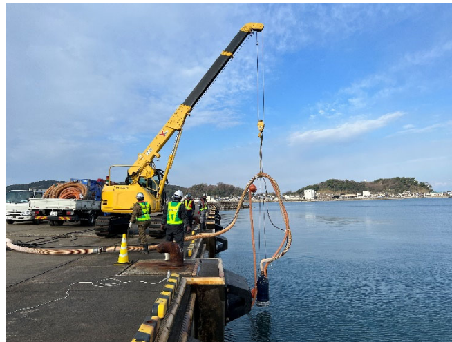
1.6 マリントウン岸壁前面水深確保(サンドポンプ浚渫)
