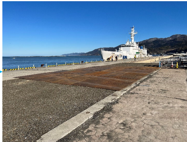
1.2 仮設通路完成【輪島マリンタウン岸壁】
