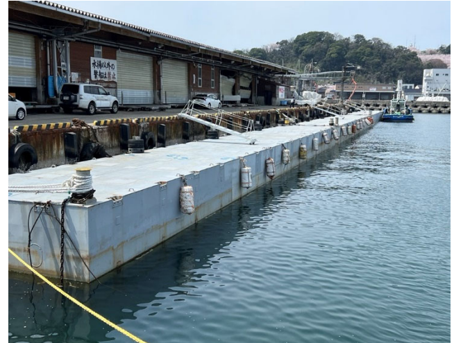
1.9 漁港区岸壁仮棧橋設置(自社所有台船)
