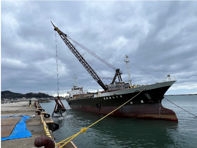
1.6 マリントウン岸壁前面水深確保(グラブ浚渫)
