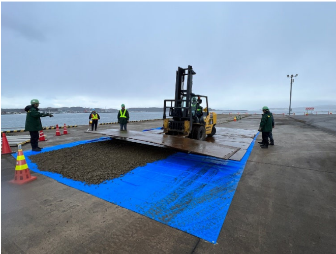
3.3災害支援船用敷鉄板敷設
