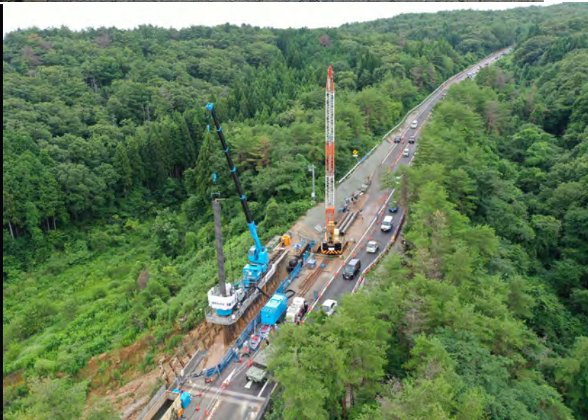
工事名 旧能登自動車道道路改良工事 その6 工 種 既設大橋（上り線） 所 点 能登大橋（橋脚基礎改修（上り線）） 鋼管杭回転圧入工 鋼管杭 荷下ろし状況
