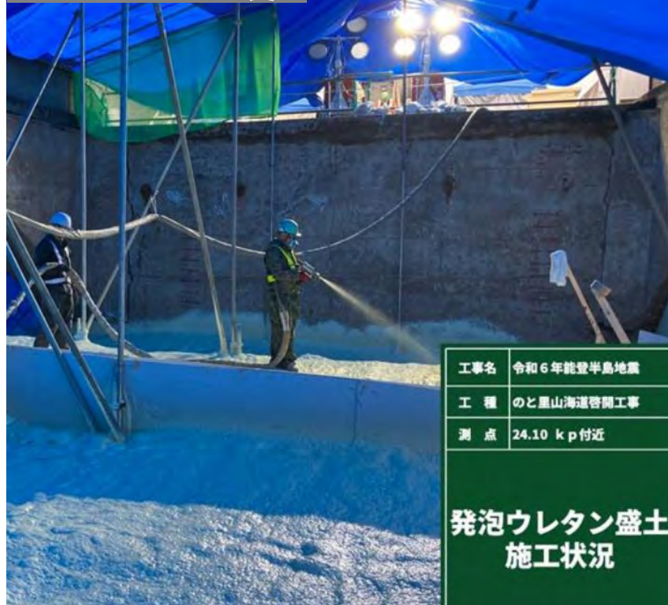
テントによる雨風養生
