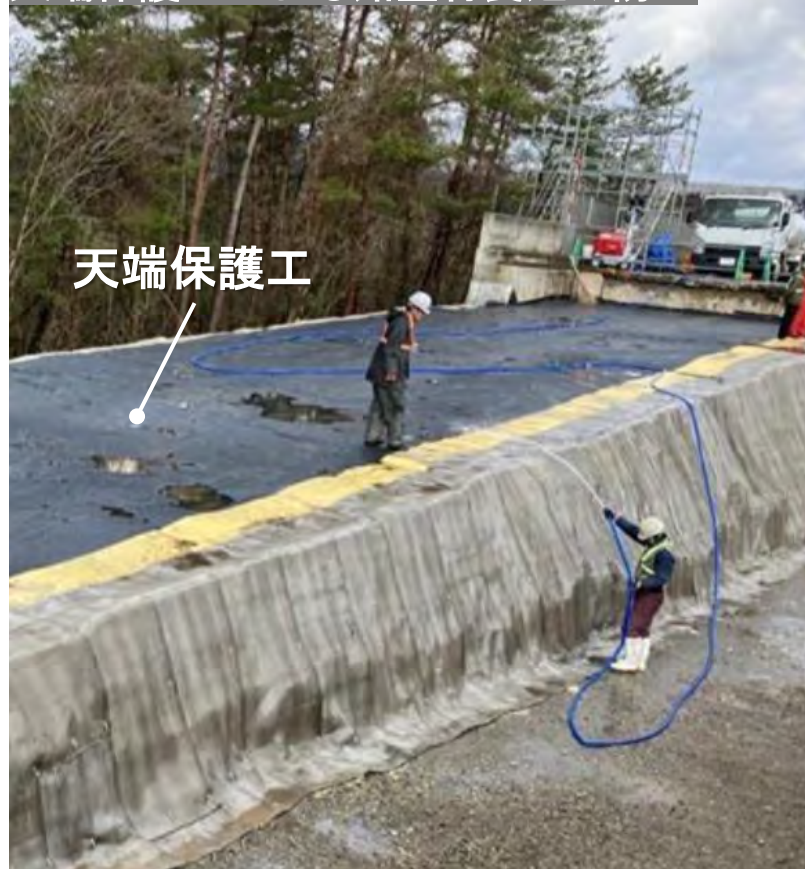
天端保護工による路盤材食込み防止
