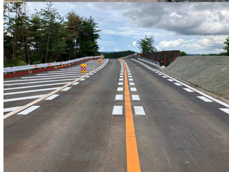
工事名 能登自動車道道路管理工事 R6 工種 能登大橋（上り線） 箇所 能登大橋（上り線） アスファルト舗装 舗装完了
