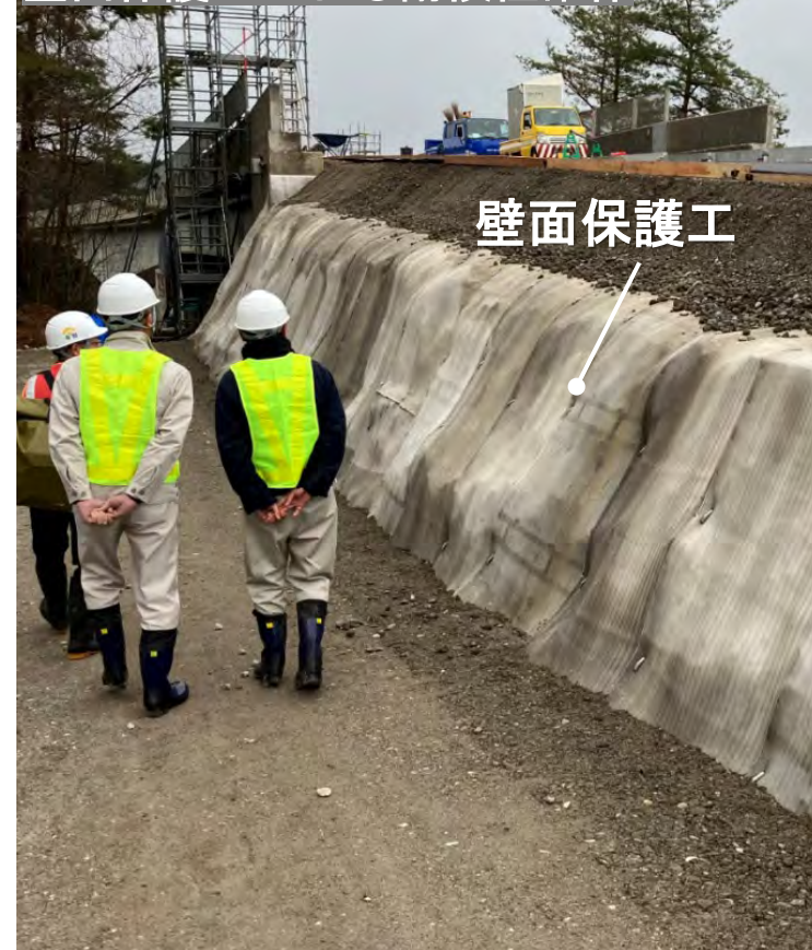
壁面保護工による耐候性確保
