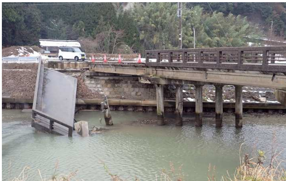
志賀町酒見大橋
