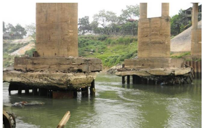
図6 崩落した橋梁
