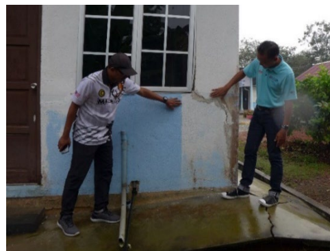
(d) Structural integrity issues on peat
