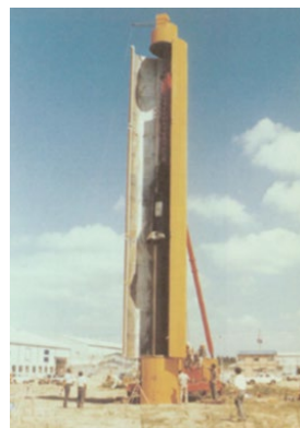
(d) Soundproof cover construction method 10)
