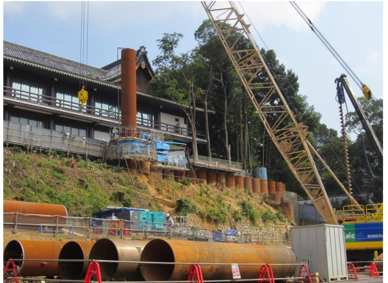
図-9. 鋼管杭圧入状況
