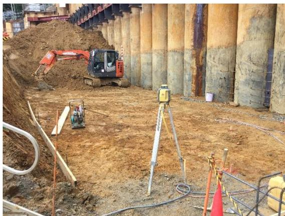
図-15. グラウンドアンカー施工後の二次掘削状況(左)および掘削完了状況(右)
