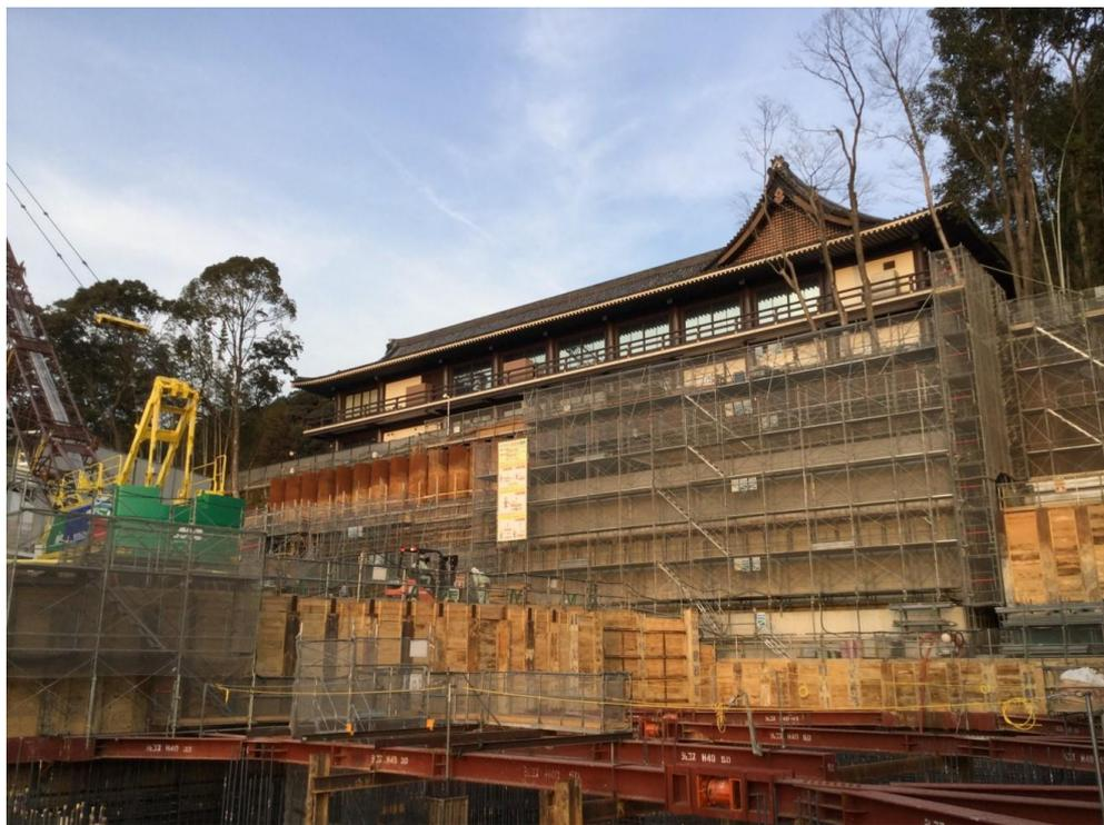
図-17. 型枠足場設置状況
