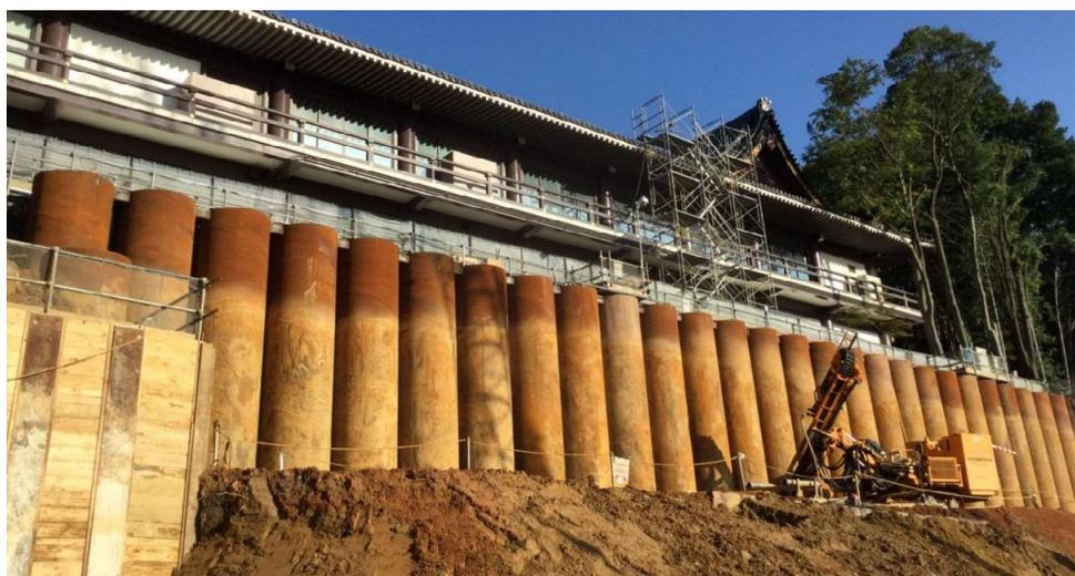
図-13. 一次掘削後のグラウンドアンカー施工状況
