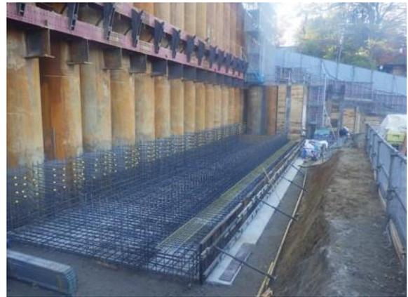
図-16. スタッドガンによる異形鉄筋スタッド施工状況(左)および施工後(右)
