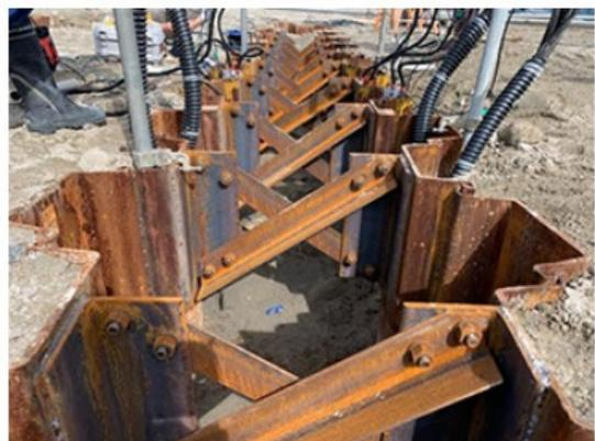
写真-2. 鋼材を用いた頭部剛結部
