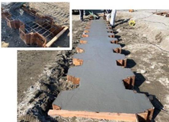
写真-1. コンクリートを用いた頭部剛結部
